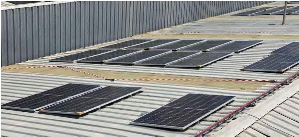
Instalación de paneles solares en el centro productivo de Torrejón de Ardoz
