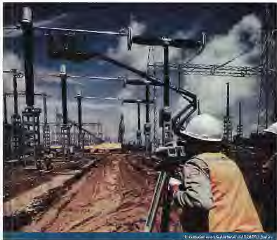
Obra de construcción de Subestación GARRASCO, Aragón
