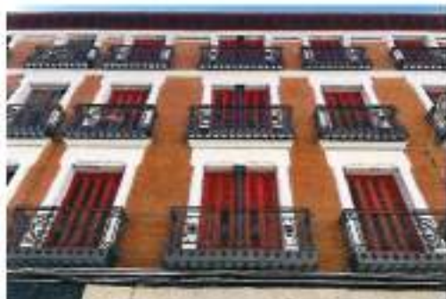
Edificio Los Madraza 5, 8 y 10
