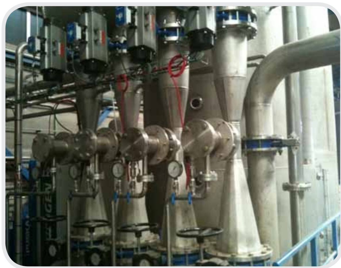
Imagen sistema de lavado del syngas
