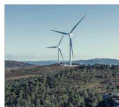
Parque eólico ALTO DA CROA II
